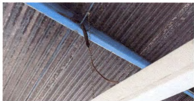
Foto 9: Sustrucción de cableado eléctrico sólido.
