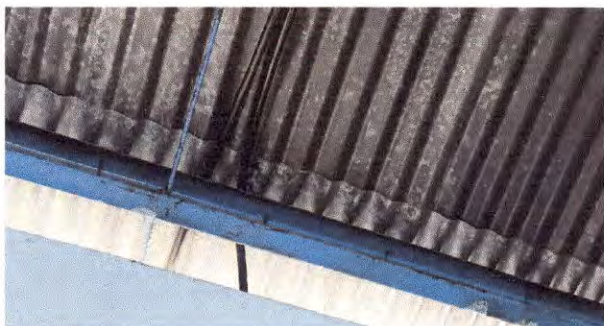
Foto 3: Sustrucción de elementos de fijación
