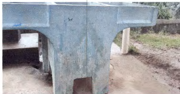
Foto: Sustitución de pila de cemento de dos lavaderos.
