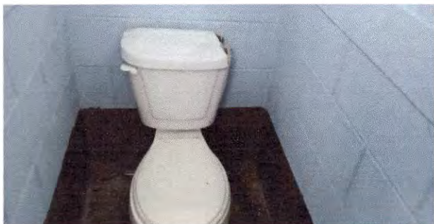
Foto 13: Instalación de inodoro.
