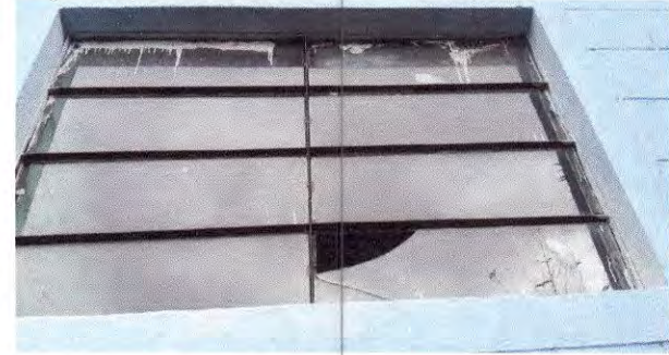
Foto 4: Sustrucción de vidrio.
