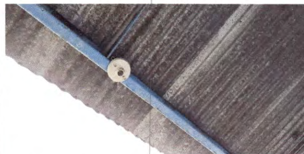
Foto 8: Sustrucción de plafoneras.
